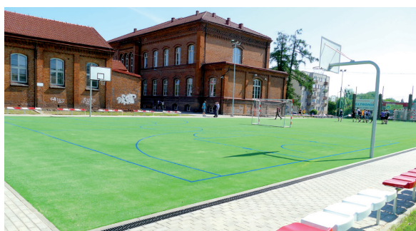
Od września 2021 uczniom CKZiU w Brodnicy przy ulicy Mazurskiej 28 służy przebudowane i zmodernizowane sportowe boisko szkolne
